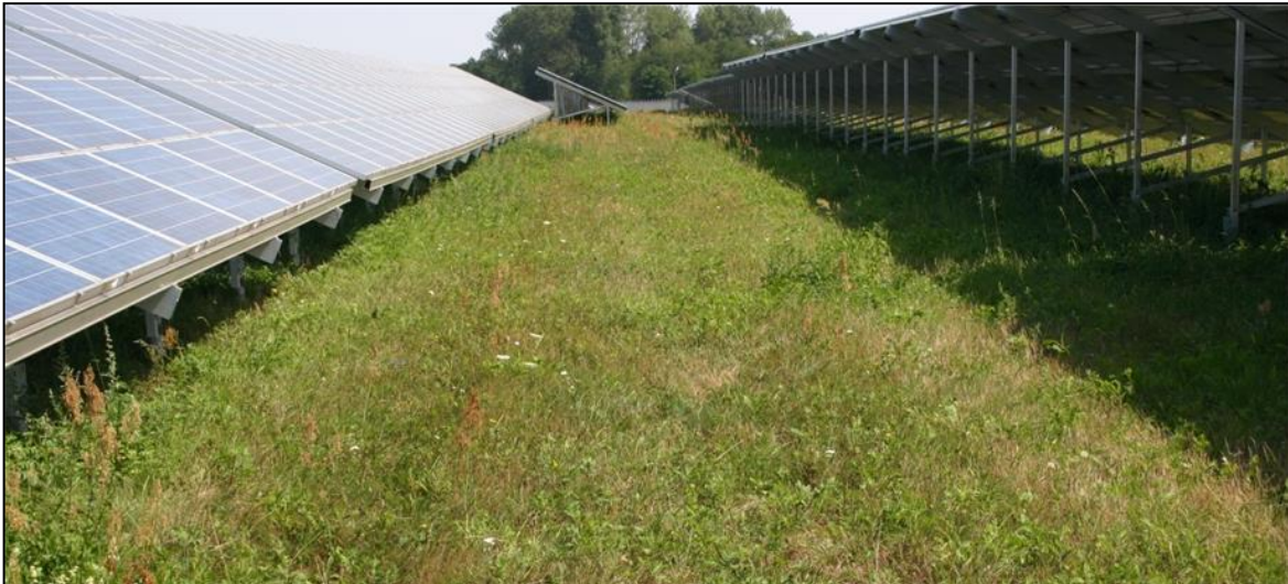
Abbildung 5: Besonnter Streifen in einer PV-Freiflächenanlage bei Werneuchen um die Mittagszeit von 2,5 m Mindestbreite (Quelle: R. Peschel)
