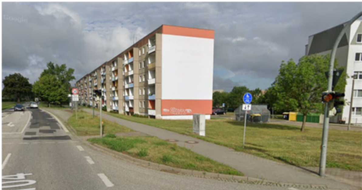
Abb. 49: Beispielhafter Block Lessingstr 20-22 Foto aus Südost 07.2022 (Quelle: Google Maps, StreetView)
