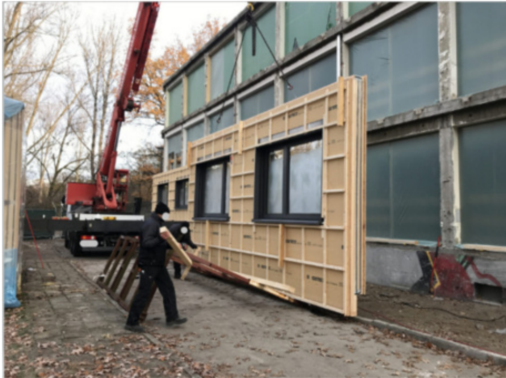
Abb. 51: Beispiel serielle Sanierung Verwaltungsgebäude Tierpark Berlin (Quelle: ZRS-Architekten-Ingenieure)
