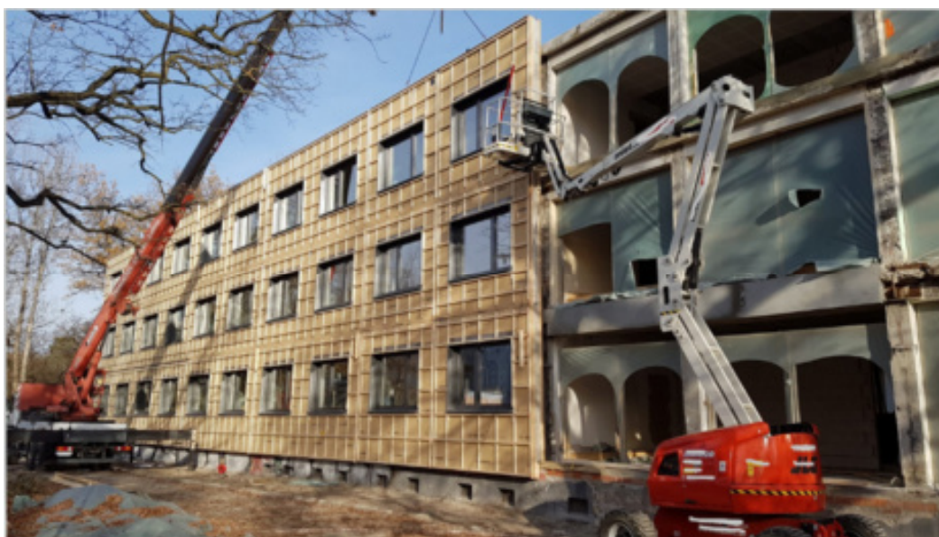
Abb. 52: Beispiel serielle Sanierung Verwaltungsgebäude Tierpark Berlin (Quelle: ZRS-Architekten-Ingenieure)
