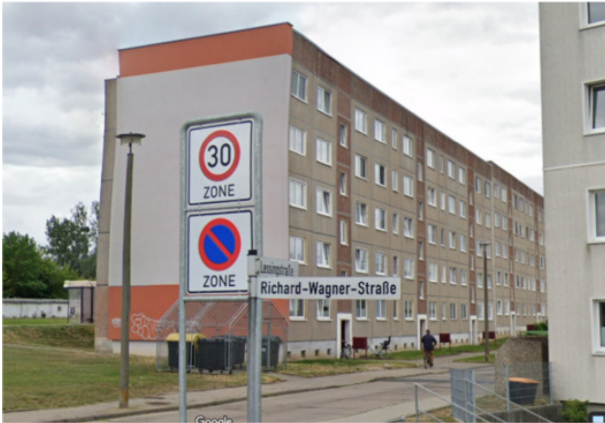
Abb. 47: Beispielhafter Block Lessingstr 20-22 Foto aus Nordost 07.2022 (Quelle: Google Maps,StreetView)
