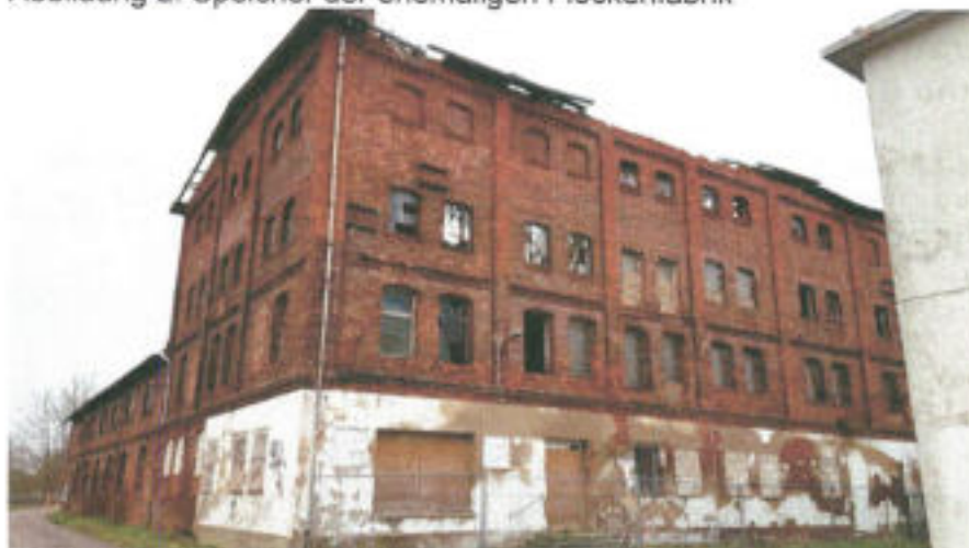
Abbildung 2: Speicher der ehemaligen Flockenfabrik
