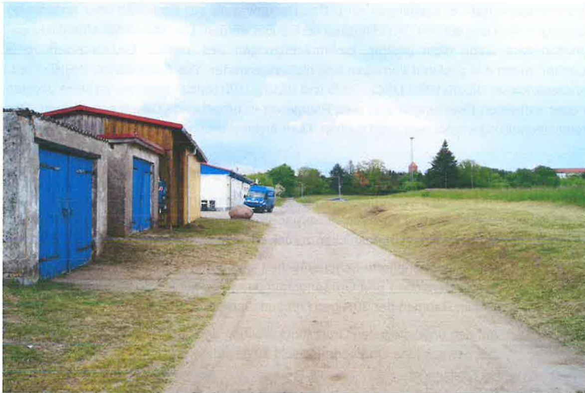
Bild 01 Straße am Wasserwerk- nordwestliche Plangebietsgrenze- Gebäude außerhalb
