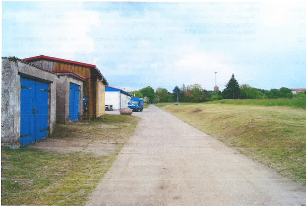
Bild 01 Straße am Wasserwerk- nordwestliche Plangebietsgrenze- Gebäude außerhalb
