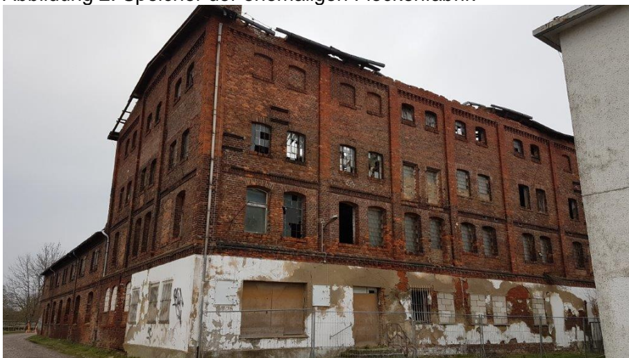
Abbildung 2: Speicher der ehemaligen Flockenfabrik
