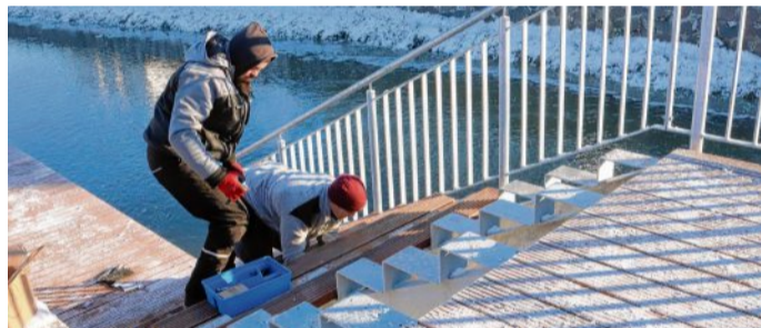
Einige Rest- und Sicherungsarbeiten sind an der Steganlage und an einem Streifen entlang der Speicherstraße noch zu erledigen.
