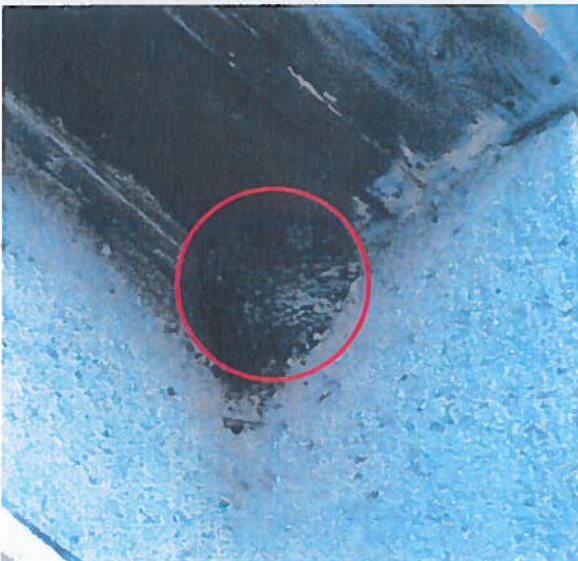
Abb. 6 bis 10 Wohngebäude in der Löcknitzer Straße mit fünf Mehlschwalbennestern am Dachüberstand und Beispiel für möglichen Einschlupf in den Dachkasten.
